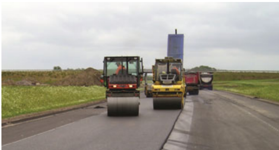
Figur 6.7 Anlægsarbejder på en vejstrækning.
