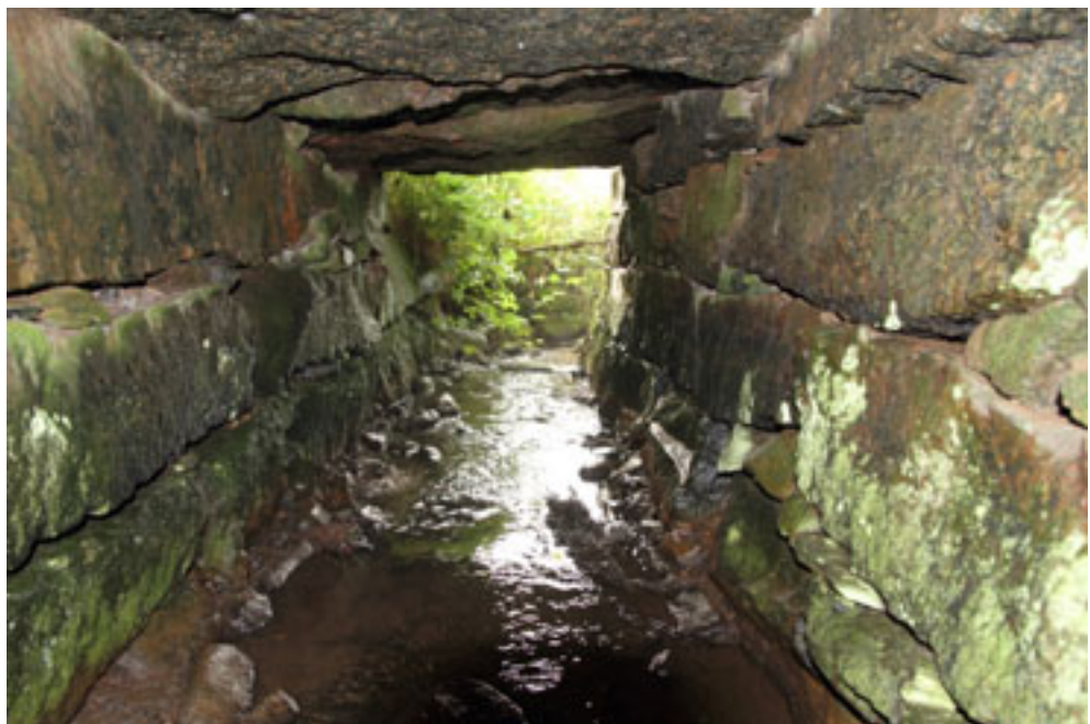
Figur 10.3 Dalby Møllebæk løber under grusvej ved Sjølundvej i gammel sten-/vejkiste.
